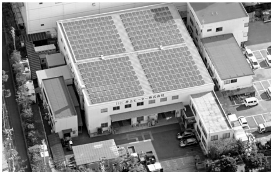
▲SDGs活動の一環として本社工場の屋上には太陽光発電パネルを設置
